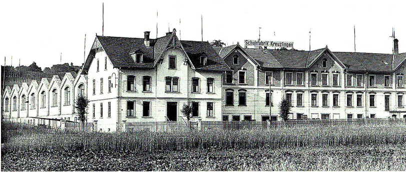
Gebäude der Schuhfabrik Kreuzlingen/Thurgau (1890)
