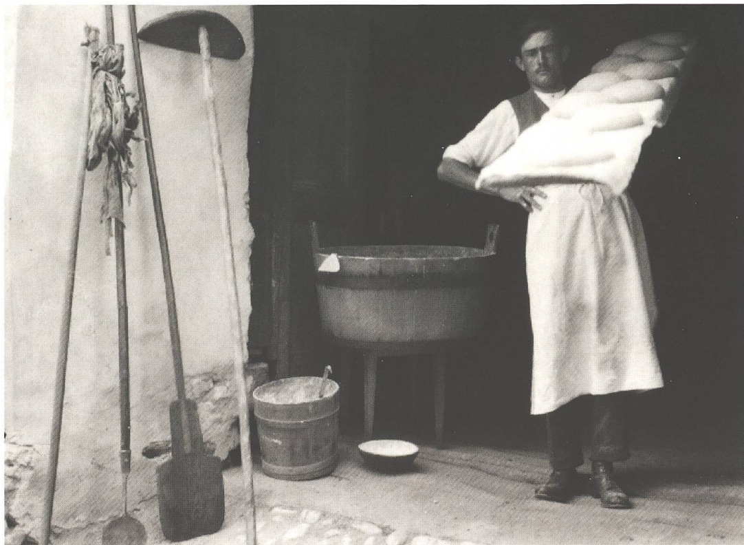
Giuvén pasterner engiadinais turnà da l'ester (Zernez 1921). Las iseglias dal furner: (da sanestra a dretga) il schlavun o scuflun cun il sdratsch vidlunder, la pala da fier, la pala da lain ed il ruschen per raspar or il charvun.
