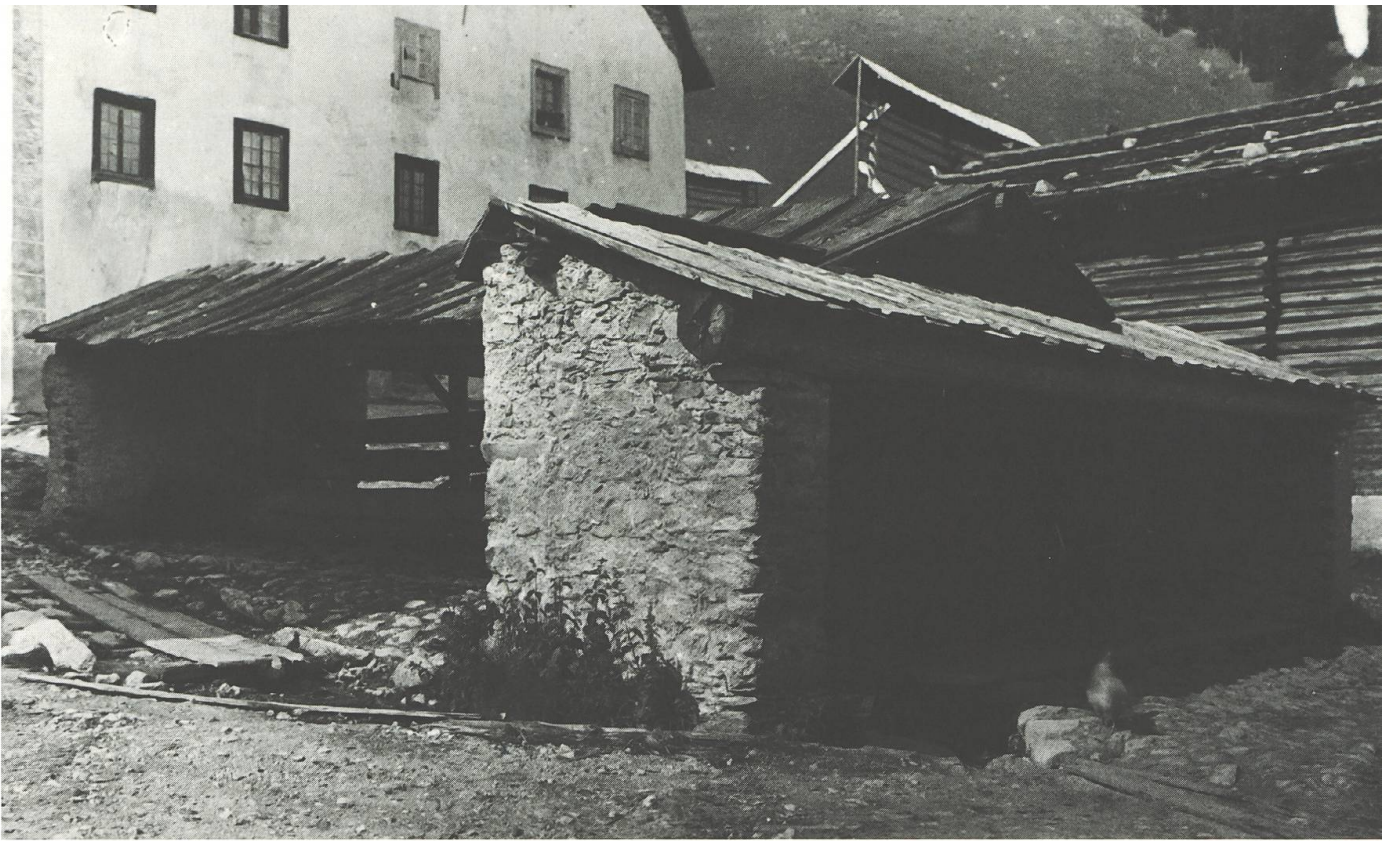
Questa construcziun davant ina chasa a Sedrun dal 1910 na para ad emprima vista gnanc in bigl, ma i sa tracta da dus bigls cuverts, colliads in cun tsel.
