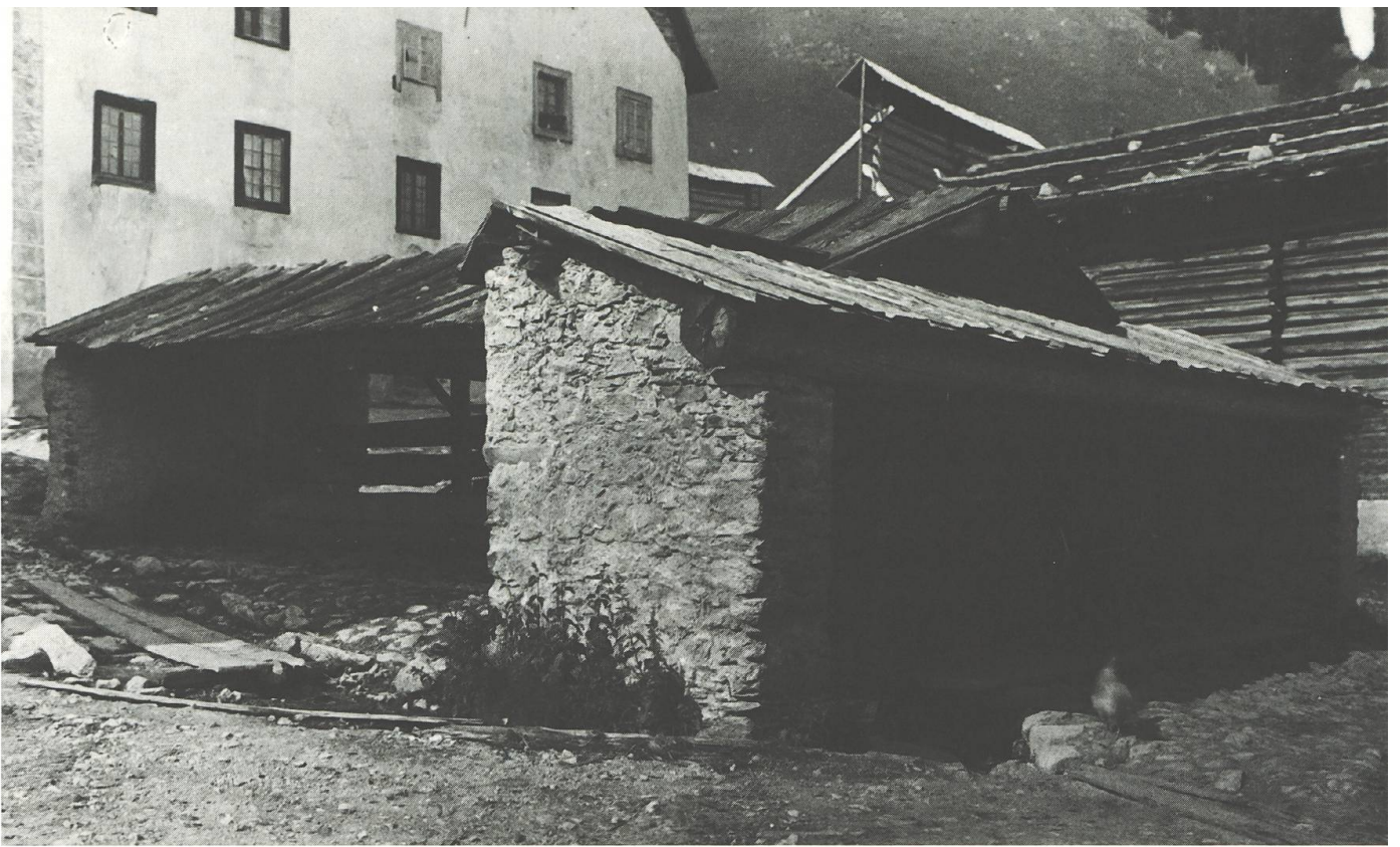
Questa construcziun davant ina chasa a Sedrun dal 1910 na para ad emprima vista gnanc in bigl, ma i sa tracta da dus bigls cuverts, colliads in cun tschel.
