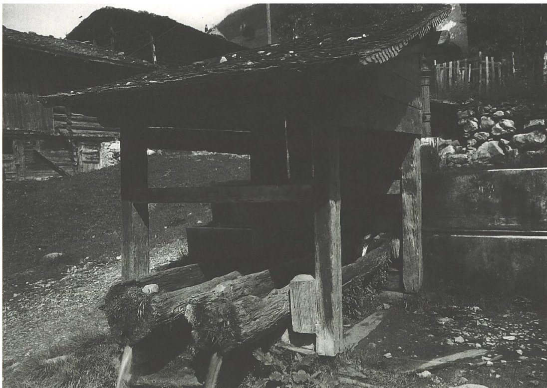
Bigl cuvert a Sumvitg. Ins vesa in toc dal bigl sura per bavarar, da cement; quel sut per lavar è fatg mo or da dus gronds lains chavads or. El nun ha nagin stapun, uschia che l'aua curra libramain vinavant.
