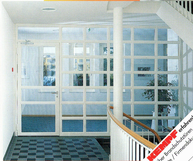
Brandschutzabschlüsse im Altersheim Dietikon ▲
