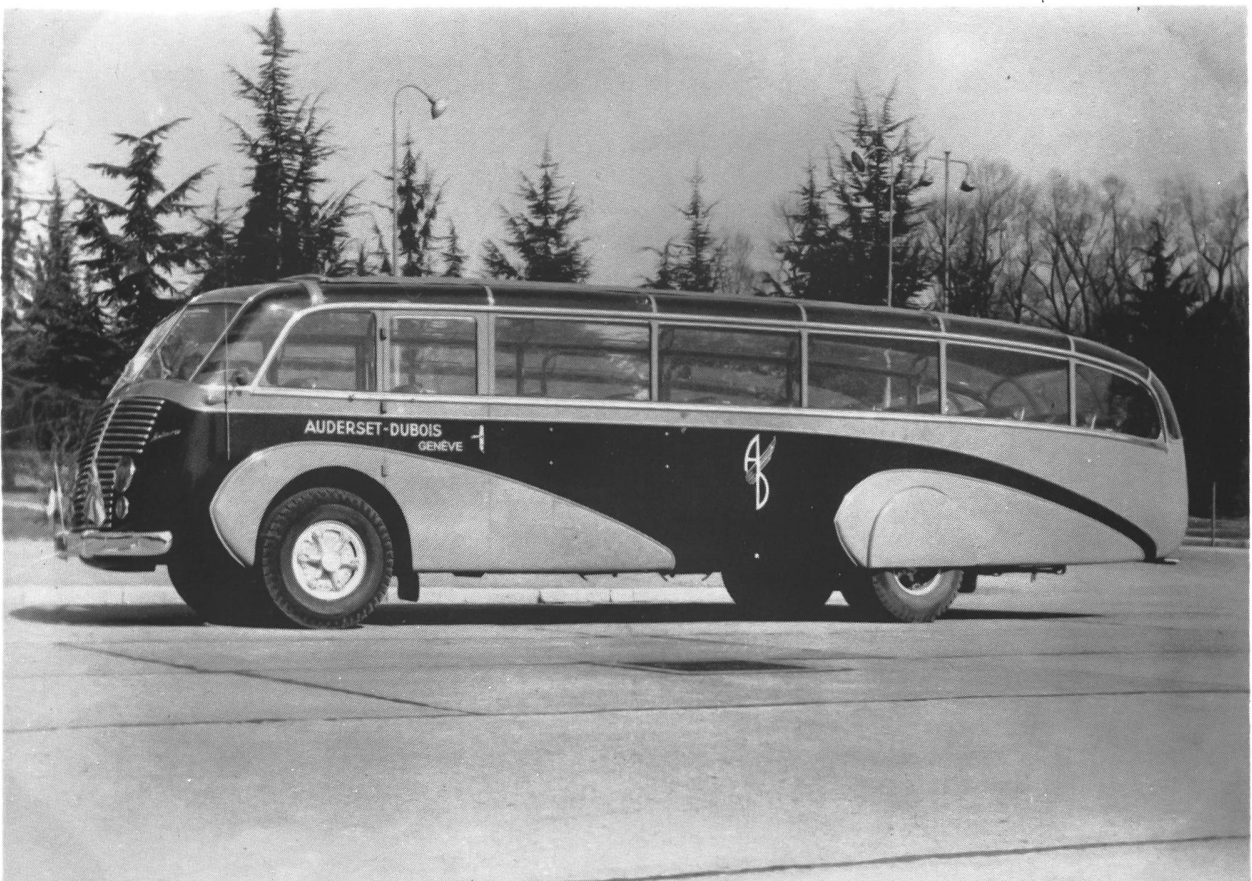
Saurer 5H-Reisebus der Firma Auderset-Dubois, Genf. Einsatz im Kursverkehr Genf-Nizza mit Bordbar und Toilette. 8-Zylinder-CH2DLM-Heckmotor mit 220 PS, quer eingebaut. (Angaben Saurer Arbon.)
