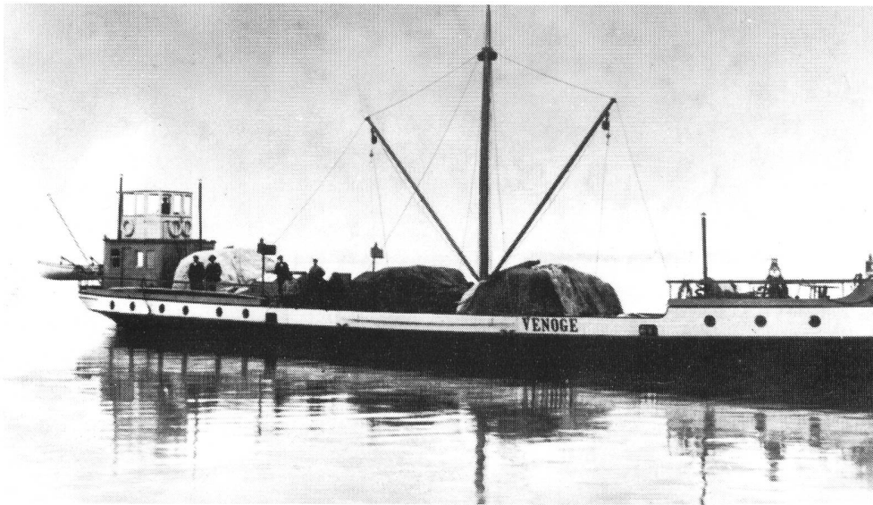
Die MS „Venoge“ auf dem Genfersee mit Sulzer's erstem, noch nicht umsteuerbaren Schiffsdiesel von 45 PS
