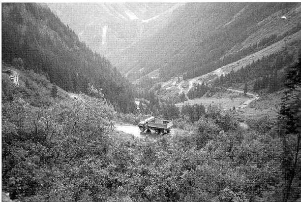
Hochalpenstrasse mit Sicht nach Partenen
