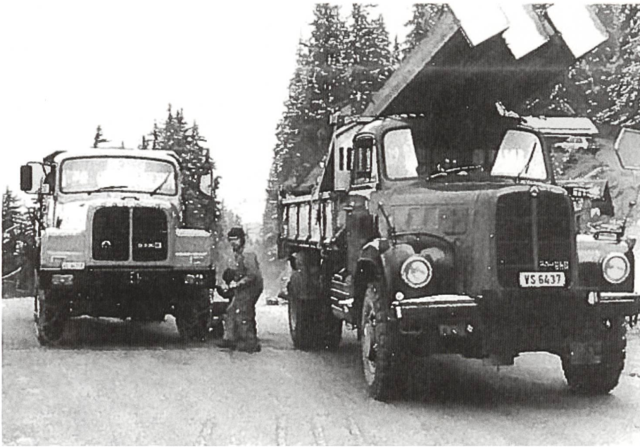
Am Anfang der «Marterstrecke». Bei aufgeweichter Fahrbahn werden hier die Ketten montiert. Die Chauffeure treffen sich zu einem kurzen Schwatz und helfen sich gegenseitig.
