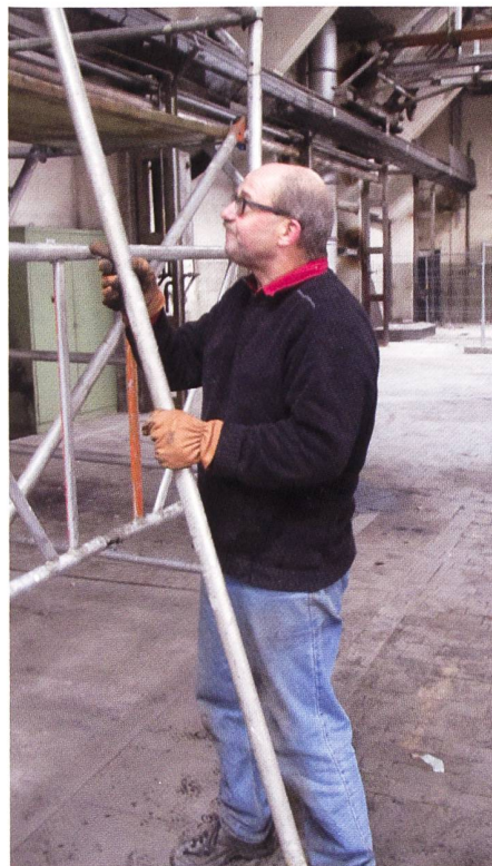
Andi bei der Gerüstmontage
