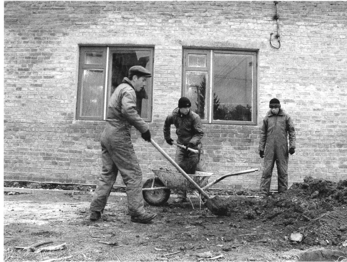
Toilettenbau für Waisenhaus
