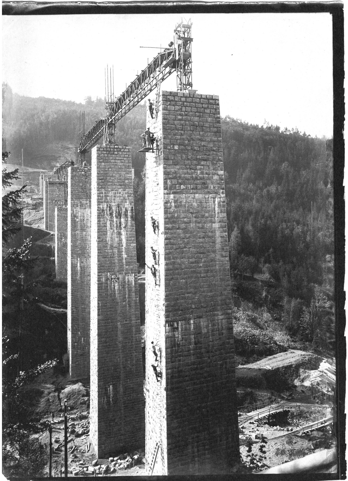
Nicht ganz Suva-gerechtes Bauen am Wissenbachviadukt.
