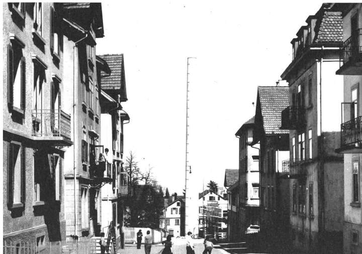
Dieser Kamin an der Speerstrasse gehörte zum Kesselhaus der Konservenfabrik Roco. Bilder.pd
