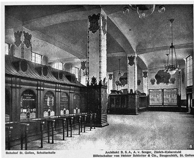
Bahnhof St. Gallen, Schalterhalle
