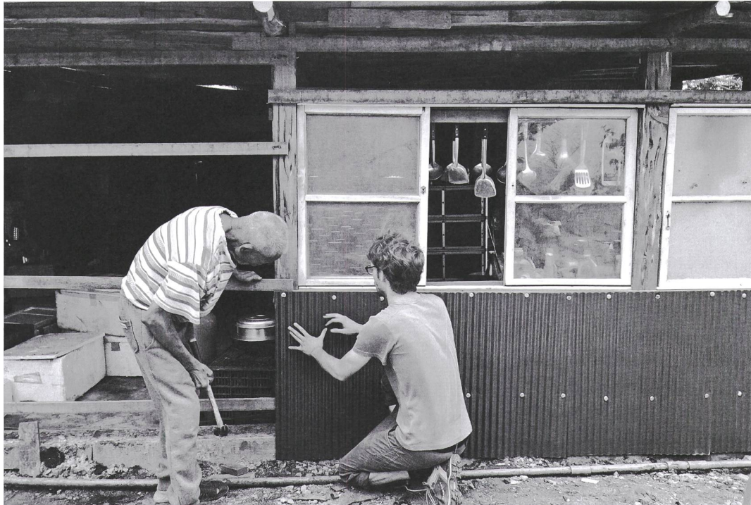
Unterstützung bei einem Neubau in den Bergen.
