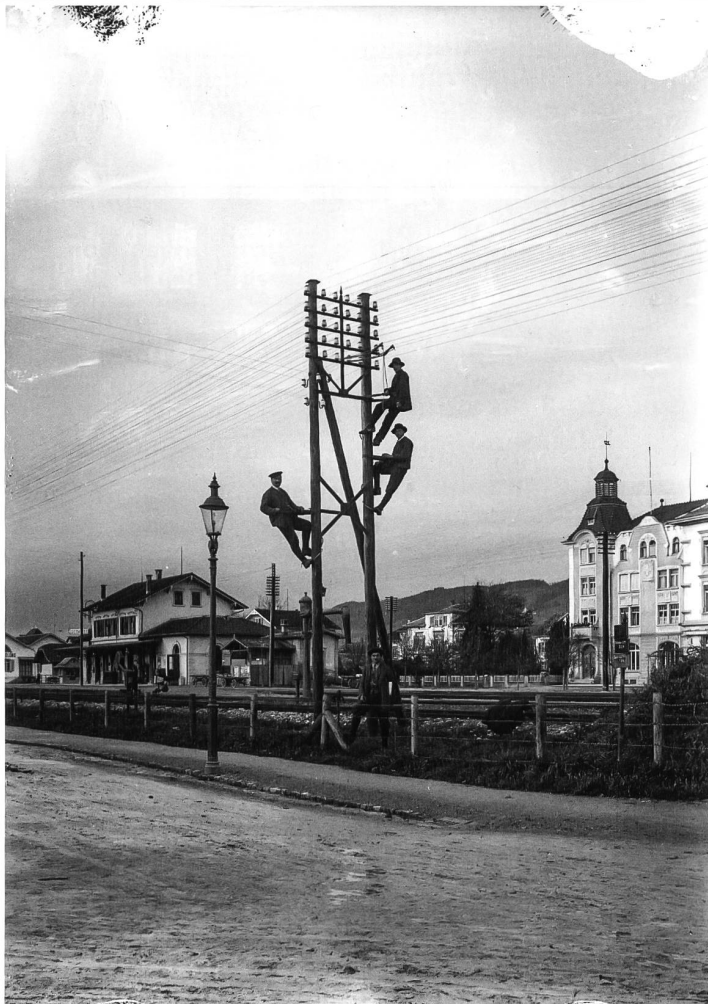
Montage von Telefondrähten beim Bahnhof Weinfelden, 1903. (Bild: Bürgerarchiv Weinfelden)
