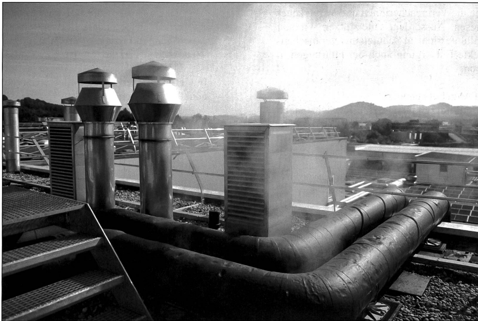
Auf dem Dach der Sutter AG. (Bild: hrt)
