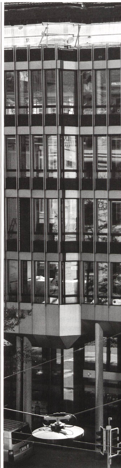
Bleibt erhalten: Die Fassade der ehemaligen Volk
