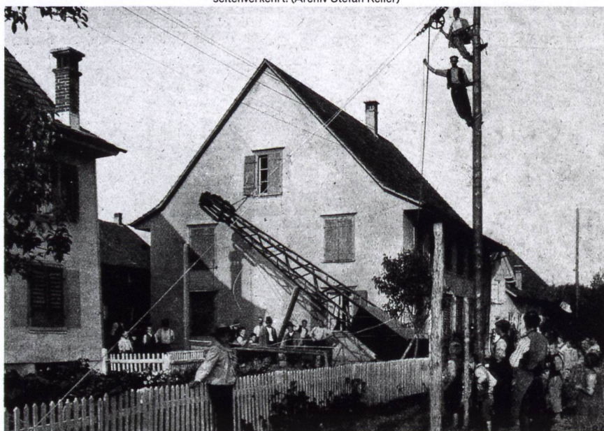
In Andwil TG wird das Stromnetz gebaut. Fotografie aus der «Schweizerfamilie» 1913, allerdings seitenverkehrt. (Archiv Stefan Keller)
