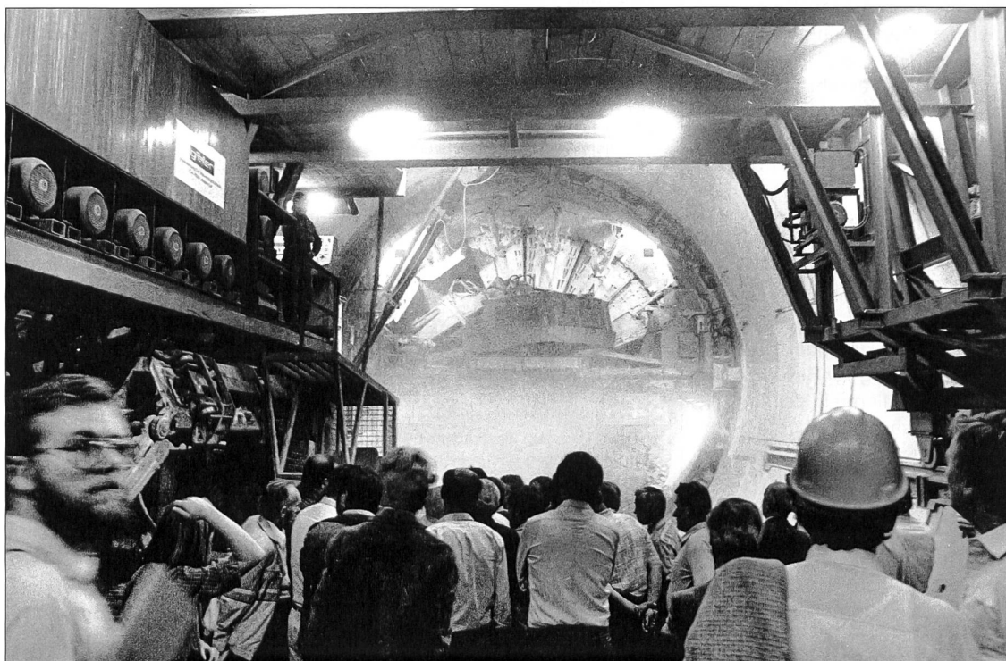
Durchstich des Rosenberg隧NELS
