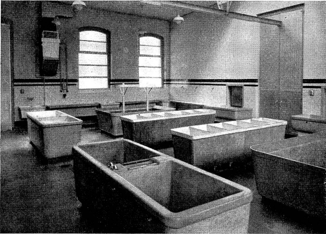
Brühraum, von Süden.
