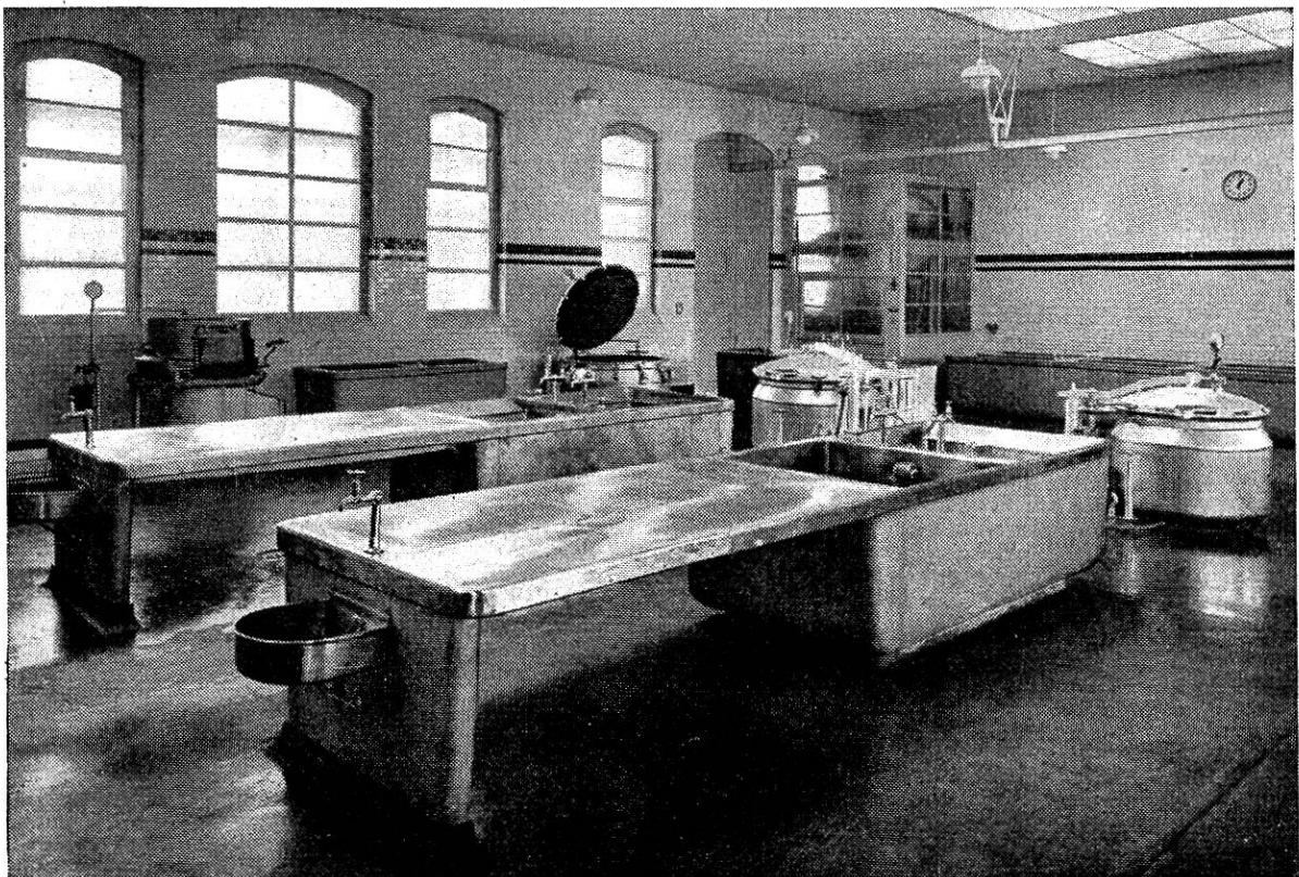
Großkuchtlei, vom Düngerentleerungsraum aus gesehen.
