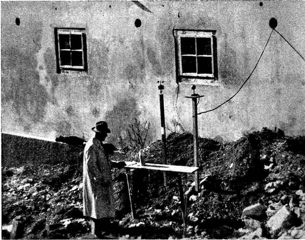
Abb. 5 Aufstellung der Instrumente im Freien vor der Nordostwand des Stalles
