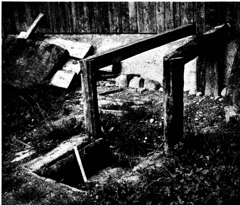
Abb. 9. Sprungstand, der seiner Gefährlichkeit wegen verboten wurde. Sprunggrube etwa 30 cm tief.
