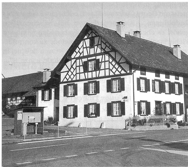
Das ehemalige Wohnhaus Seilers im heutigen Zustand in Benken ZH
