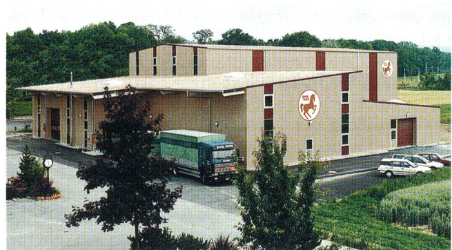
Neues separates Hochregallager mit Werkstatt.
