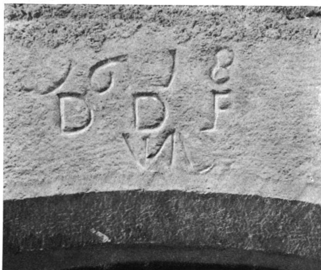
Fig. 9. Marque Dufour sur la porte de cave (Bâtiment du Vieux-Montreux)
