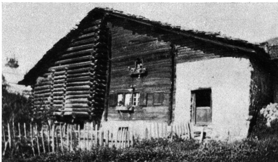
Fig. 8. N° 30 avec habitation et fenil sous le même toit.
