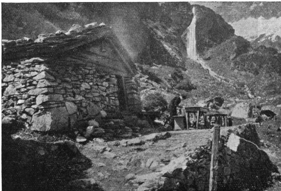
Fig. 9. Alte Alphütte in Kuhplanggenalp.
