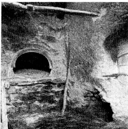
Fig. 2. Les « enfers ». A gauche, bouche du four à pain bouilli, à droite, celle du four à pain de ménage portant une date (1882) qui est peut-être celle de construction. Au-dessous, le trou du braisier. Au-dessus, la poutre où reposent les outils pendant la chauffe et où l'on pend les porcs (on aperçoit deux sillons d'usure dus au frottement des cordes de suspension).
