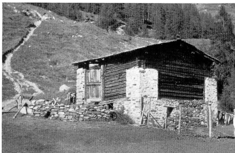
Fig. 28 – Alpe pozžòl presso La Rösa. Fienile e stalla con zoccolo e pilastri di pietra e con la parte superiore a cruséra .
