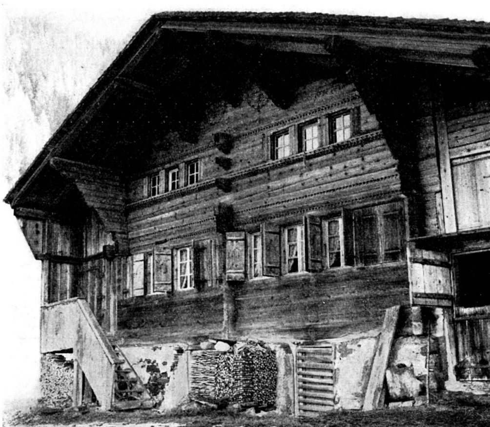
Fig. 16. – En Aigue-Noire-Diablerets. 1645. Cette maison ressemble étrangement aux constructions du Pays d'Enhaut et du Gessenay. Rien d'étonnant, puisque le constructeur de ce bâtiment est le maître charpentier Claude Dubac, de Rougemont. (voir Kitchin et Henchoz. 1929. N o 64)
