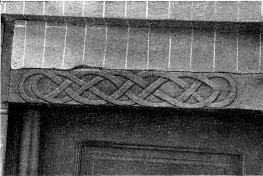
Fig. 6. Rossinière. Grand Chalet. (travail du XVI e siècle) (antérieur à la cons- truction de la maison. Apport d'une précé- dente construction.)
