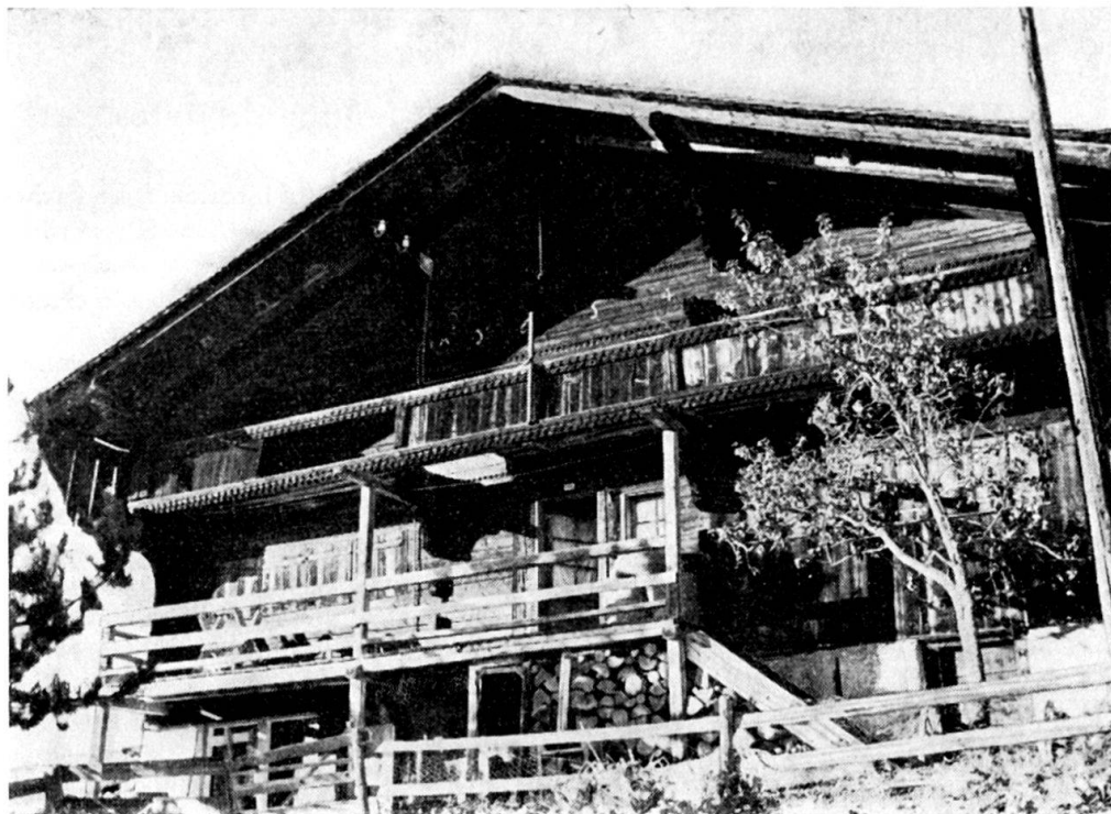
Fig. 17. Aus Voêtes, lieu dit: Le Marguet, 1654. Type de construction réunissant à un haut degré les traits essentiels des maisons de la région. A comparer les lettres et la forme des chiffres gravés sur la façade avec l'inscription n° 92.
