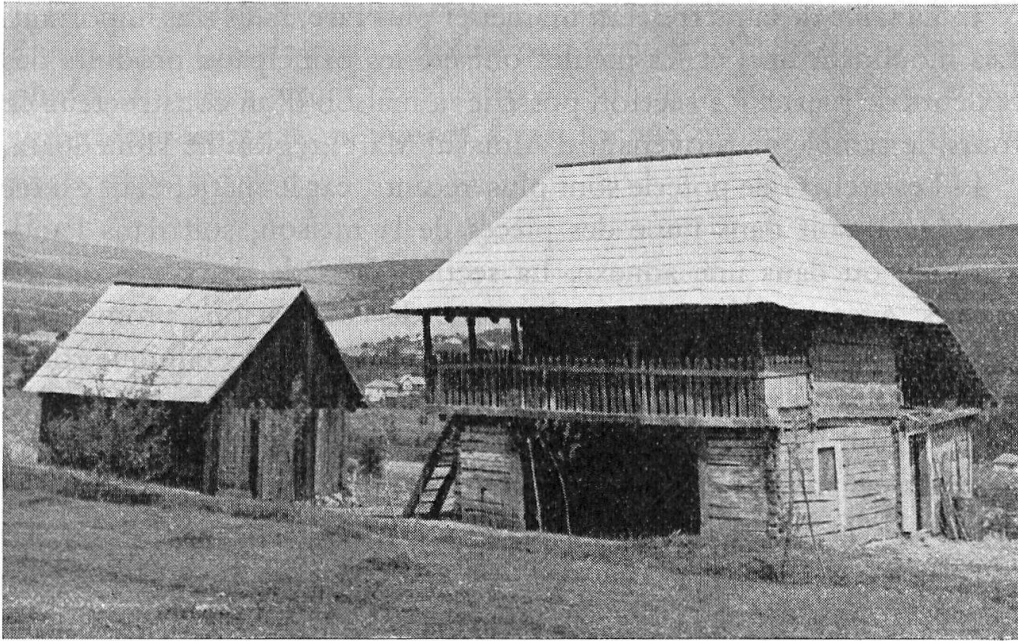
Fig. 4. Constructions du secteur des presses à huile.
