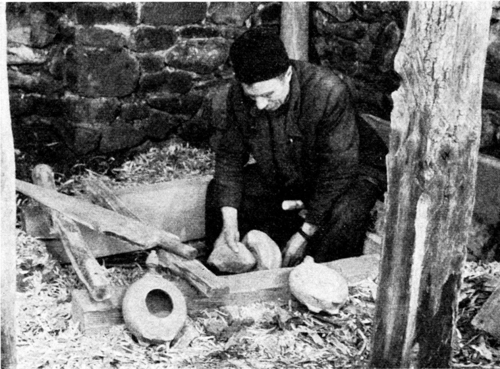
Abb. 1. Drechsler für Feldflaschen in seiner typischen Arbeitsgrube.
