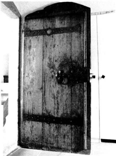
Abb. 3: Sakristeitüre Lausen, äussere, d. h. dem Kircheninnern (Chor) zugewandte Front (nach der Beschädigung). Nach der Form des Schlosses ca. 16. Jh.
