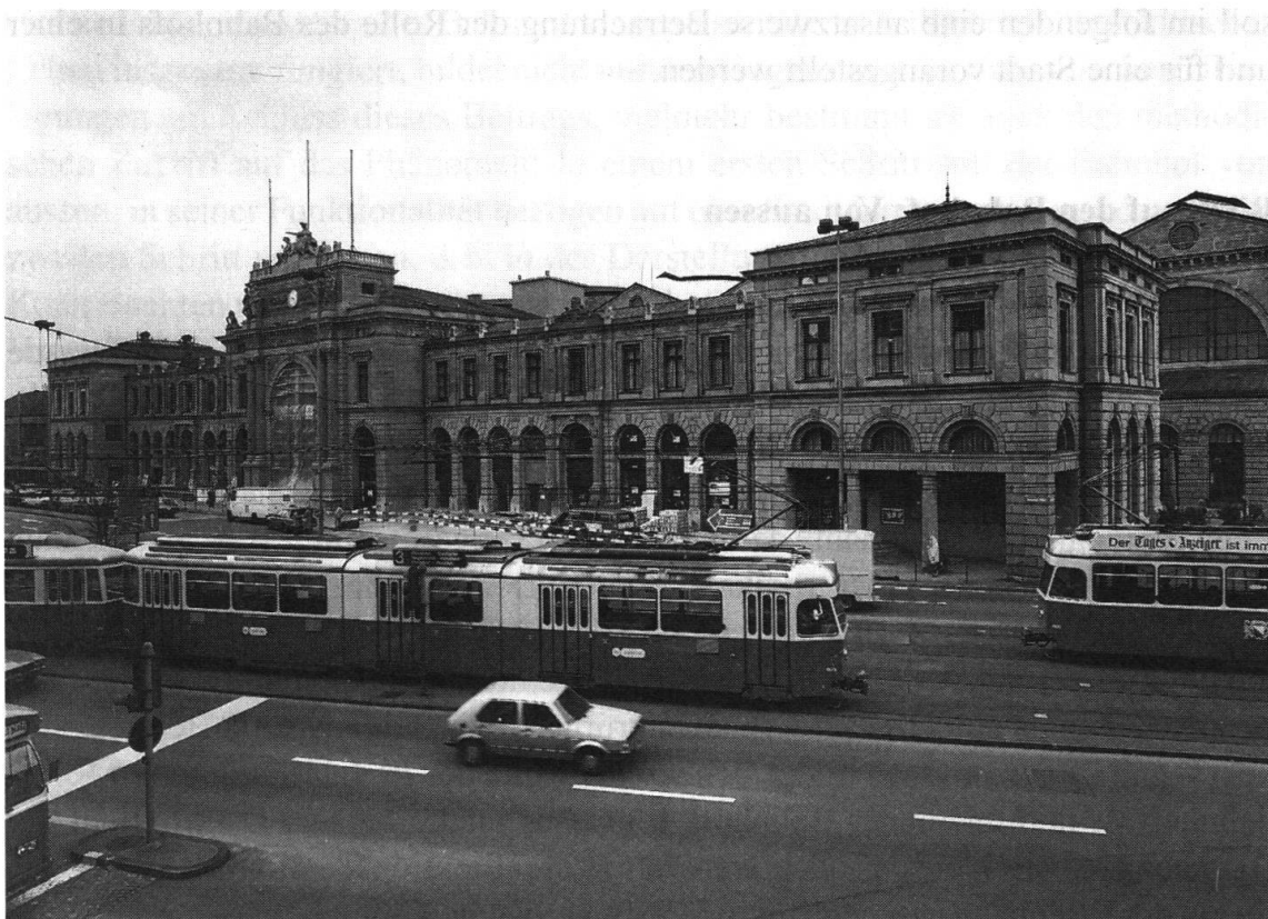
Der Bahnhof bildet mit seinem überdimensionierten Tor in der Hauptfassade einen sicht- und erkennbaren Ort mit einer weit über die zweckbedingte Grösse hinausreichenden architektonischen Hülle. © Archiv SBB.
