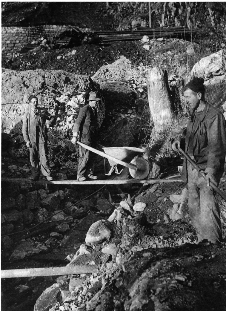
Planierungs- und Sicherungsarbeiten beim Klusbach
