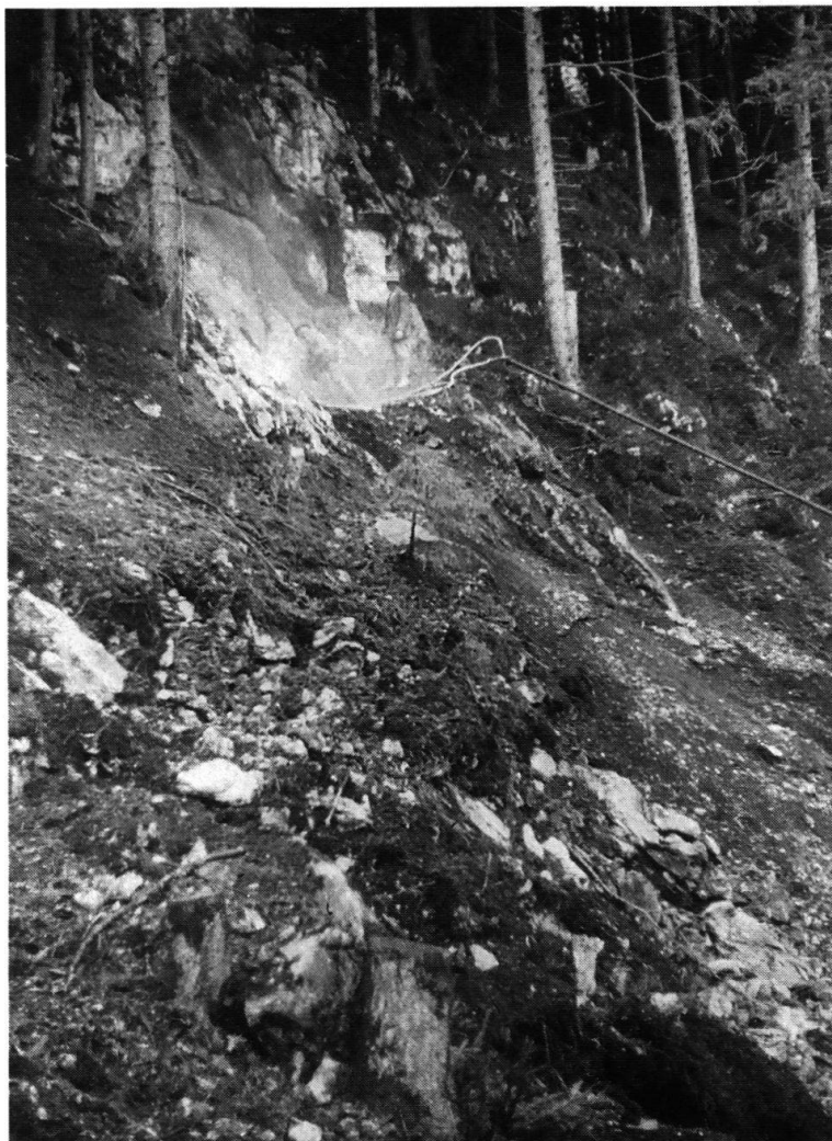
Erste Sprengungen für Dürrifluh- Grundstrecke
