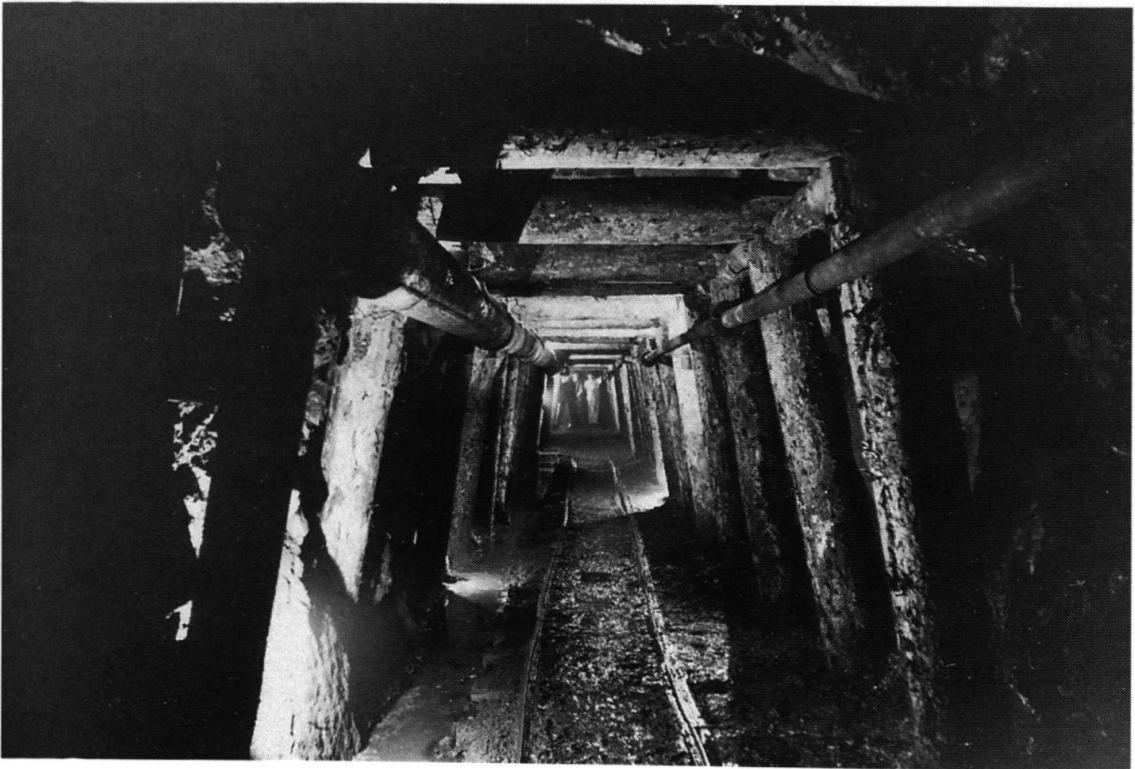
Die Grundstrecke will gut gesichert sein
