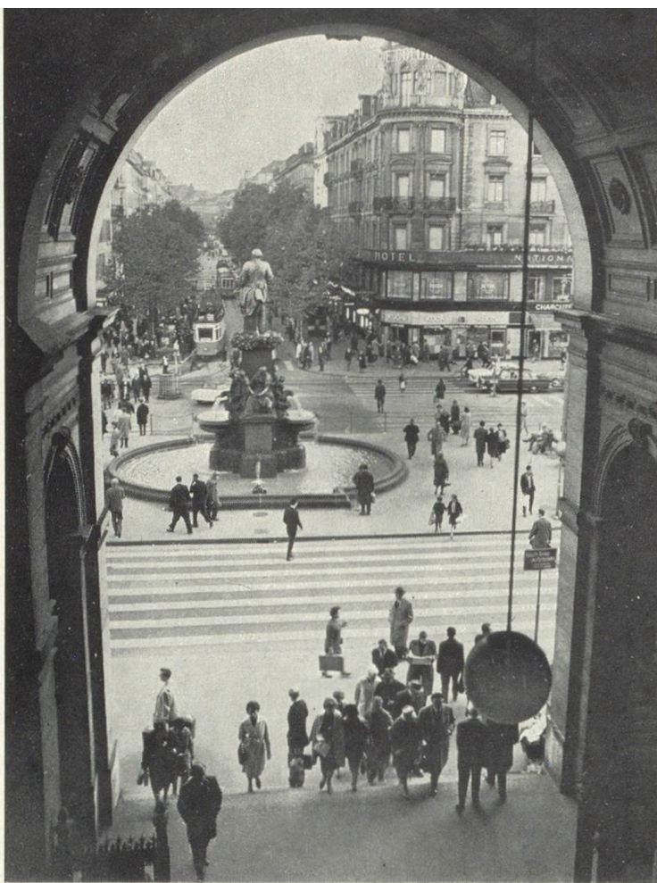
Zürich einst: Blick vom Bahnhofsausgang auf Escherdenkmal und Bahnhofstraße
