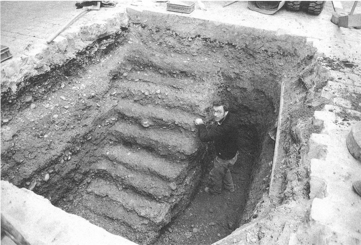
Abb. 10: Verschiedene Kieskoffer der städtischen Hauptstrasse aus dem 12.–14. Jahrhundert, treppenartig freigelegt über einer Pflasterung des 11. Jahrhunderts.
