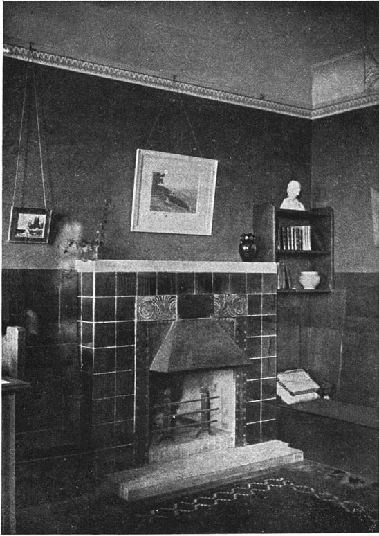
Cheminée für Holzfeuerung aus glatten Fliesen
