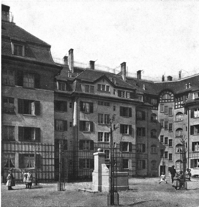
Blick in den Hof des ersten Hausblocks von Osten Photographien von Wolf-Vender, Zürich I
