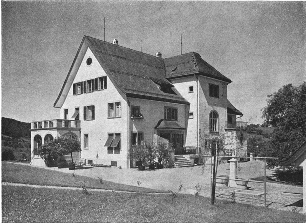
Ansicht der Fassade mit dem Haupteingang
