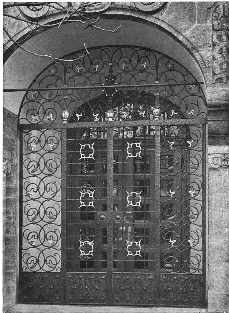
Portal der Rhätischen Bank in Chur Schäfer & Nisch Architekten B. S. A.
