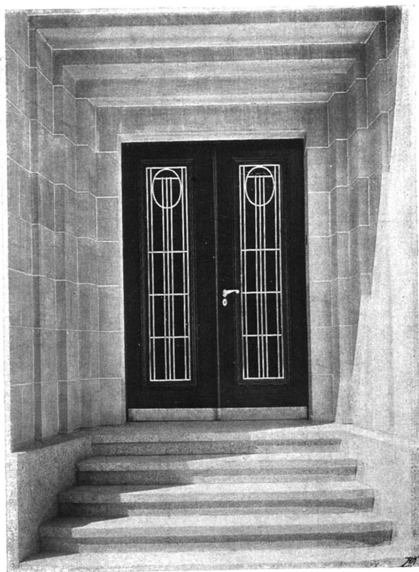
Eingang zum Flügelbau Türe in Eichenholz, ausgeführt von Hoffmann & Hauser in Zürich Gitter in Durana-Metall von Heinrich Zili in Zürich V
