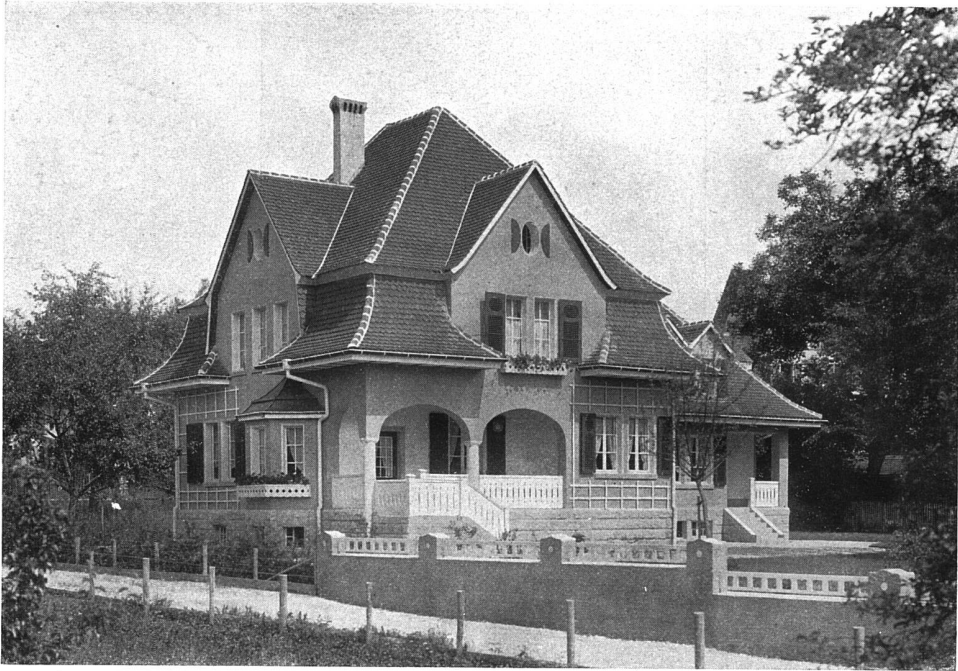
Ansicht der Südfassade
