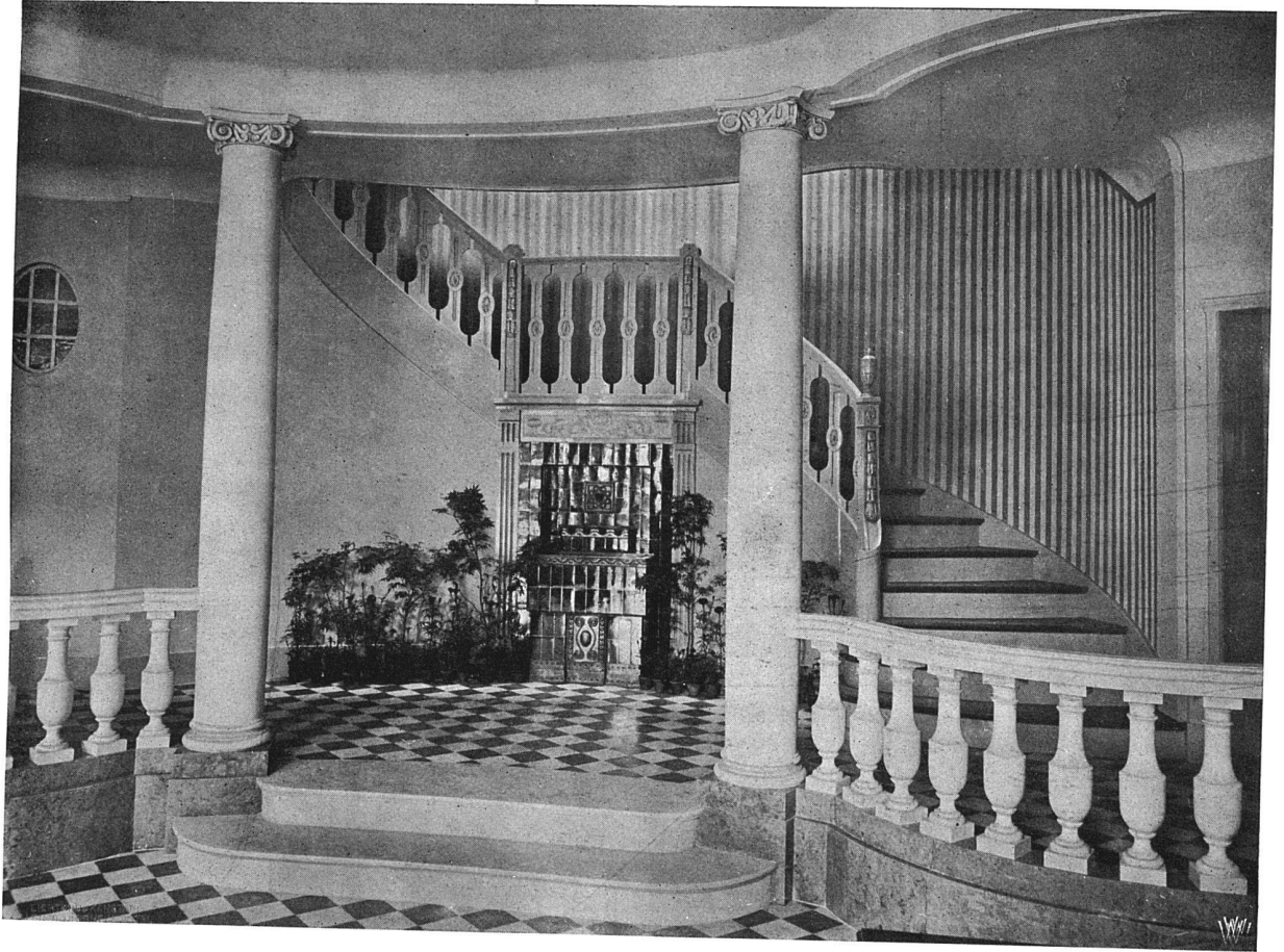
Gartensaal mit Treppe.
