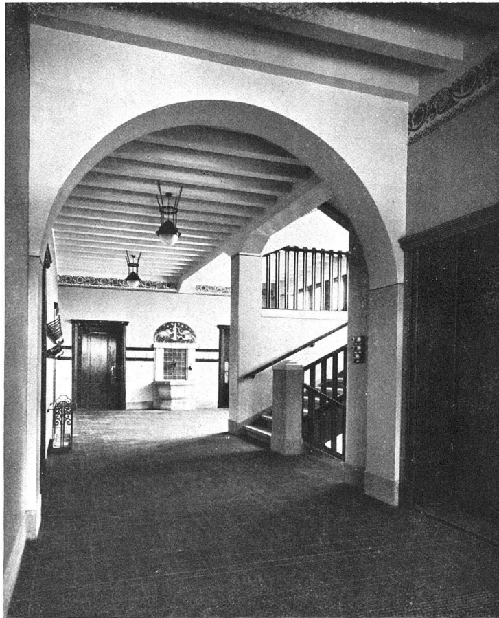
Schulhaus Buchthalen Vorplatz im Treppen- haus :: Parterre ::
