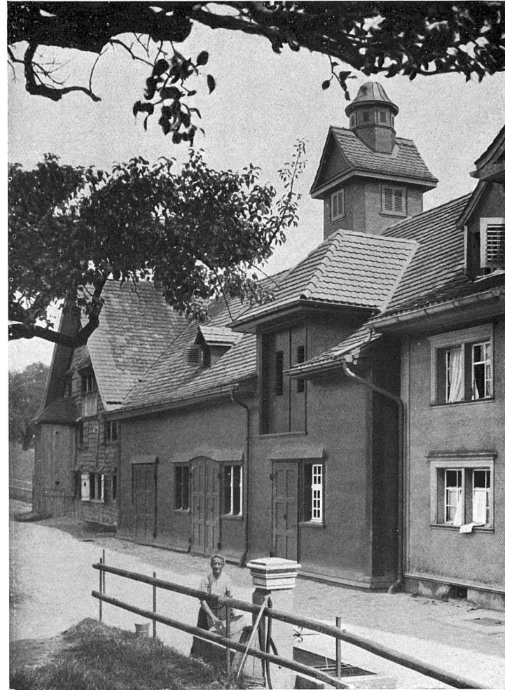
Eingebauter Stall im „Kreckel“ in Herisau.
