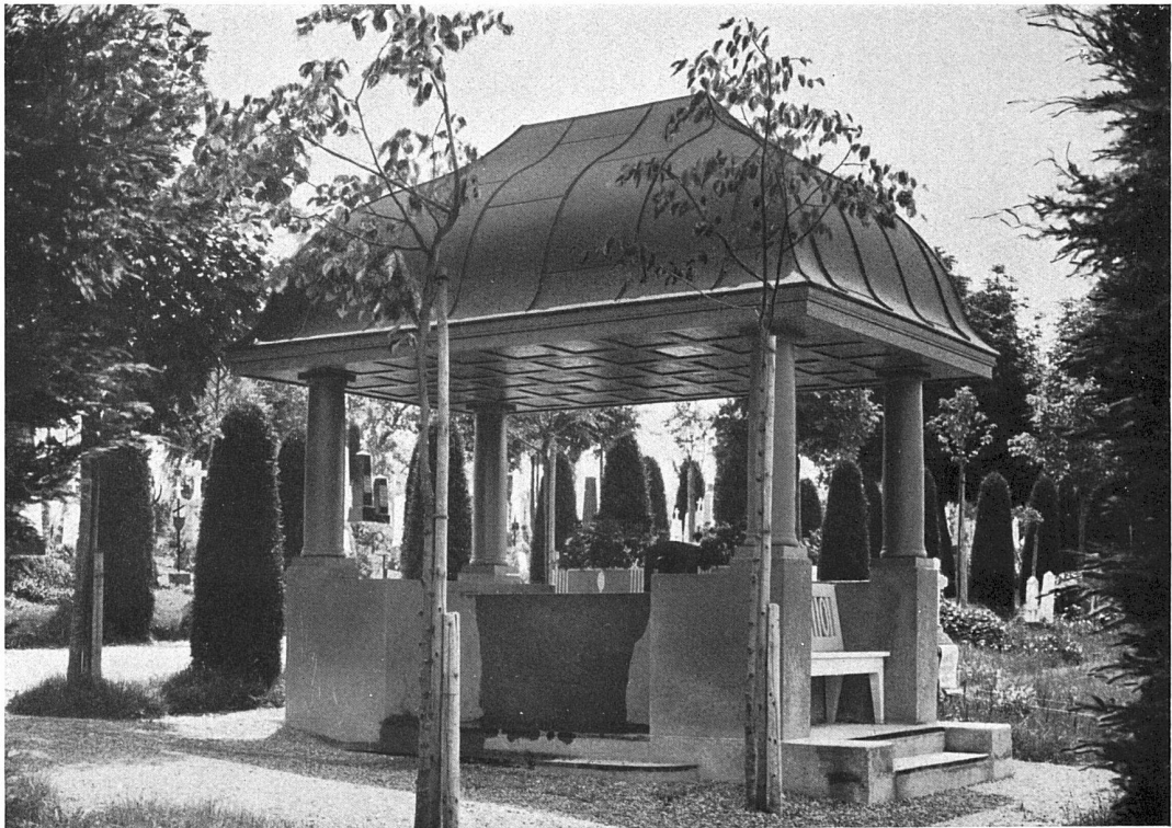
Brunnenanlage im Friedhof in Herisau. Architekt Alfred Ramseyer, Gemeindebaumeister, Herisau.
