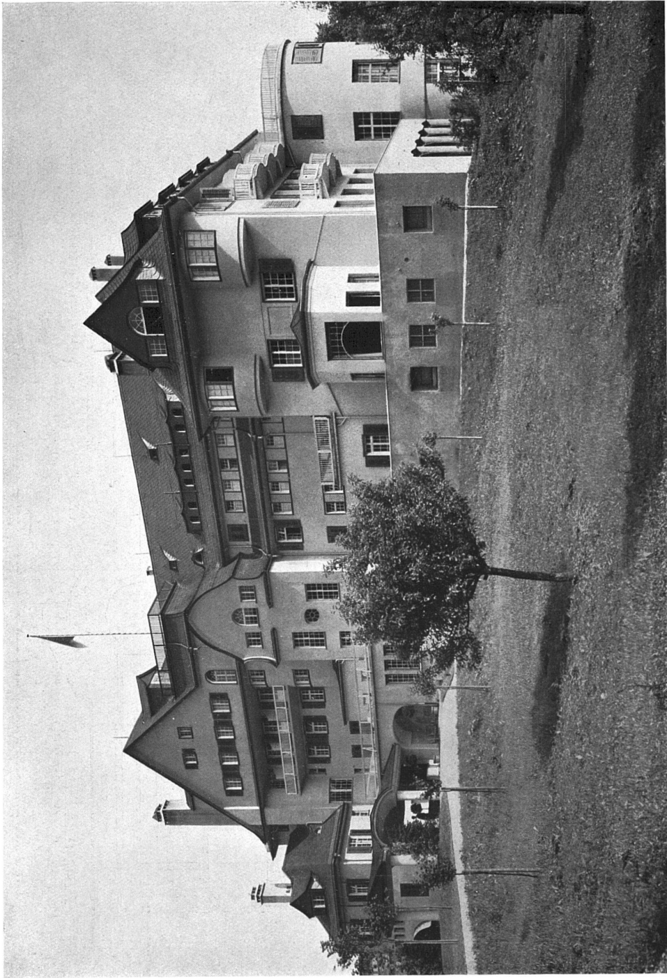
Das Kurhaus «Sonn-Matt» bei Luzern. — Die Nordwestseite mit Anfahrt. Architekten Theiler & Helber, Luzern. Aufnahmen von Ph. & E. Link, Zürich.
