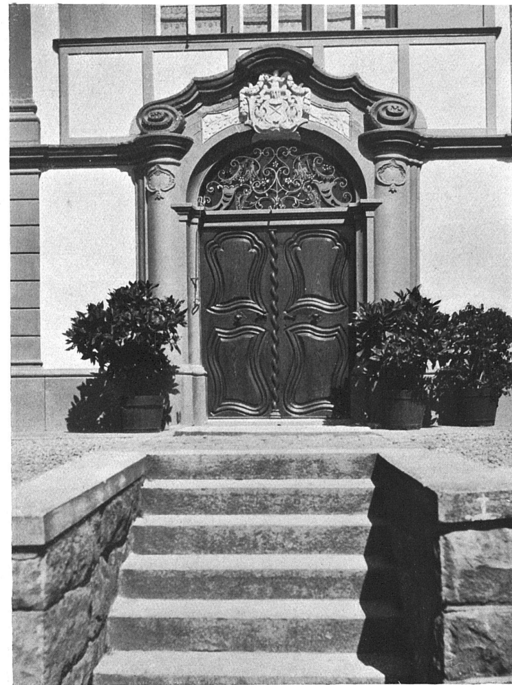
Das Portal des Hauses Brenner zu Gais (Appenzell A.-R.)
