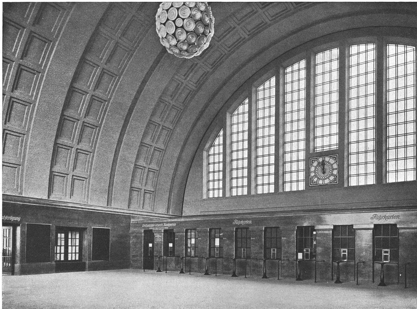
Das Aufnahmegebäude des badischen Bahnhofes zu Basel. — Die Schalterhalle. Architekt Professor Karl Moser (Curjel & Moser), Karlsruhe.
