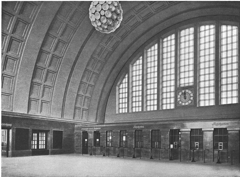
Das Aufnahmegebäude des badischen Bahnhofes zu Basel. — Die Schalterhalle. Architekt Professor Karl Moser (Curjel & Moser), Karlsruhe.
