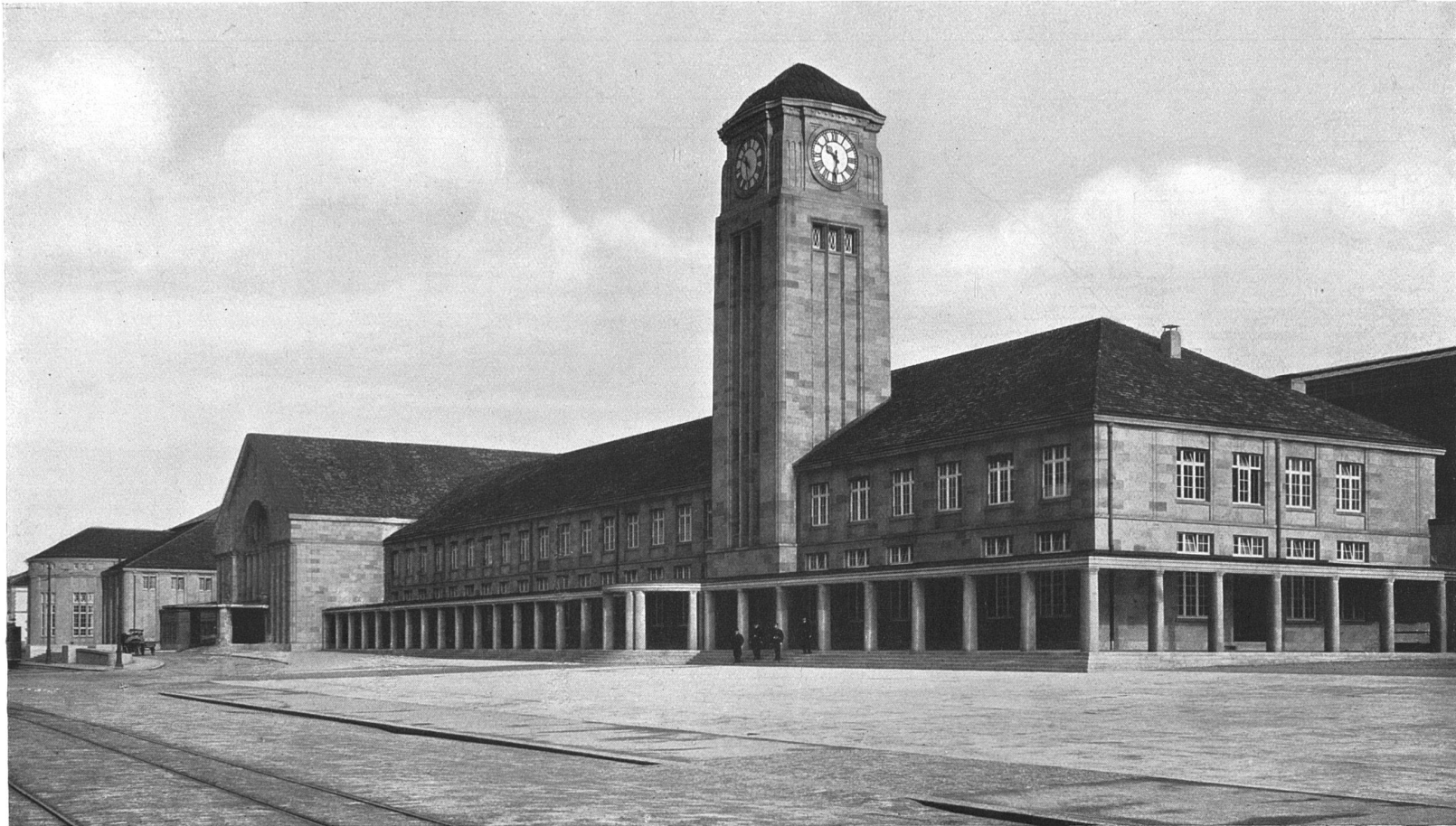
Das Aufnahmegebäude des badischen Bahnhofes zu Basel. — Die Gesamtansicht. Architekt Professor Karl Moser (Curjel & Moser), Karlsruhe.
